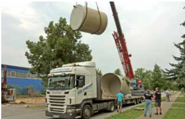
Anlieferung der vorgefertigten Bauteile
