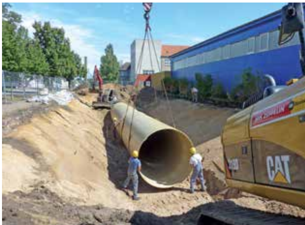
Versetzen der Rohrelemente
