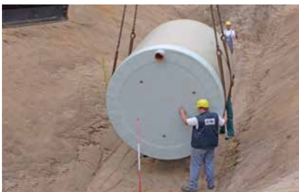
Versetzen des ersten Endstückes
