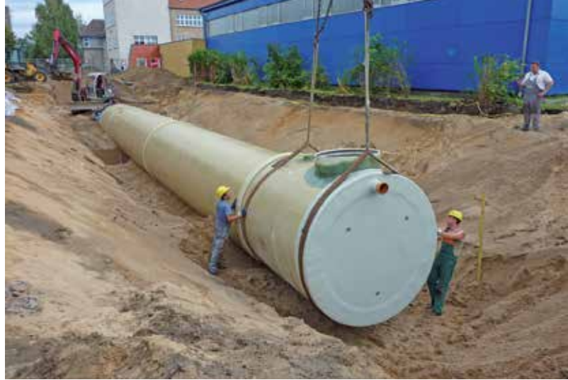
Versetzen des zweiten Endstückes
