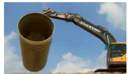
Transport der Bauteile mit dem Bagger
