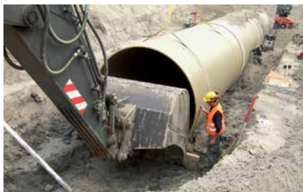
Zusammenschieben der Bauteile mit dem Baggerlöffel
