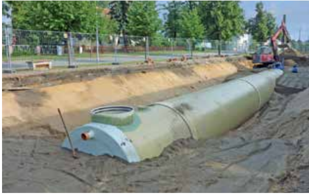
Verlegter Löschwasserbehälter DN 2400
